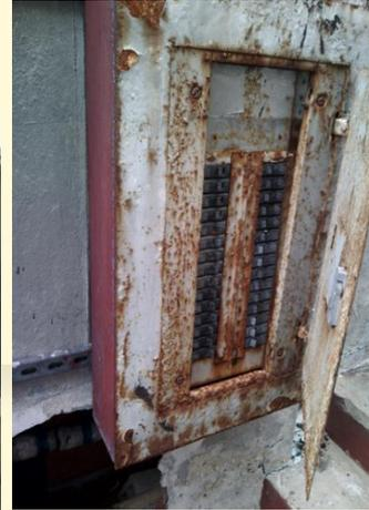
Evaluación del nivel de afectación del Sistema Eléctrico en edificio incendiado en Colón, con apoyo de los Estudiante de la FIE.
